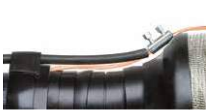
Połączenie z wyprowadzeniem uziemienia
